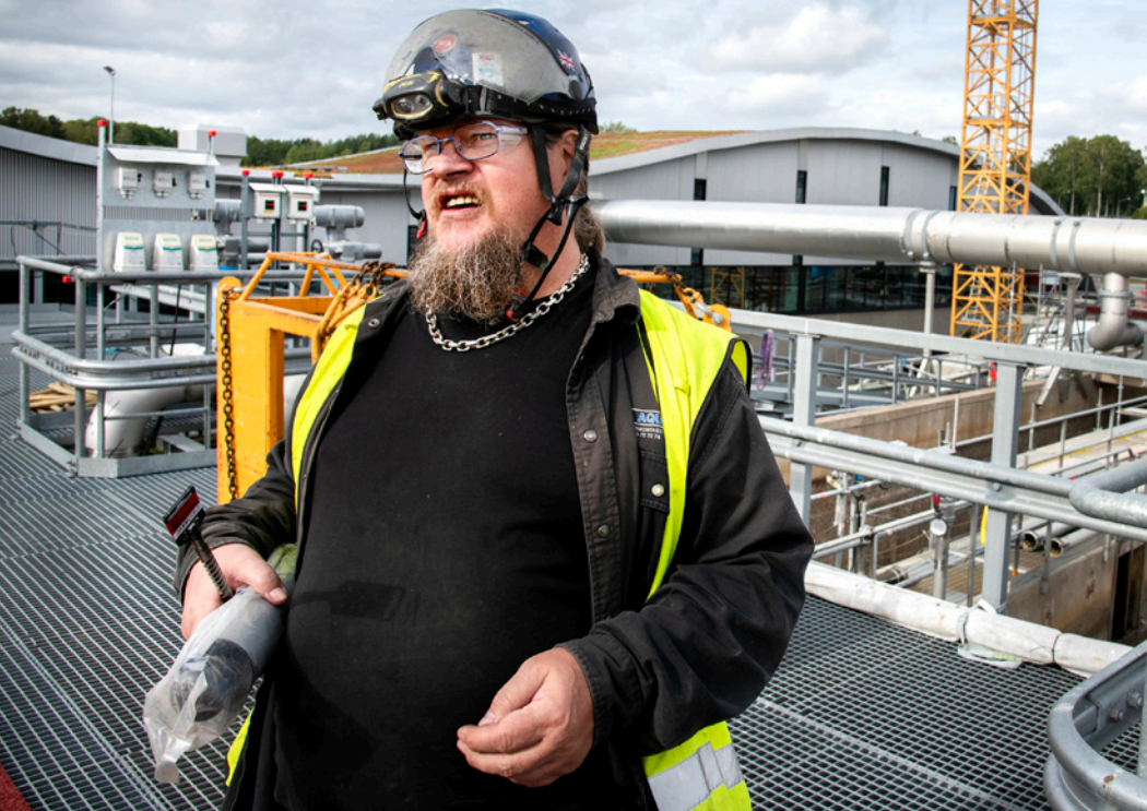
Svetsaren Patric Carlsson tycker att det är bra med de morgonmöten man har på bygget för att dela information med varandra.
