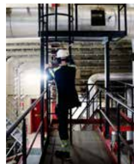
Inne i värmeverket har man monterat en permanent stega med fallskydd. Här inne bär man också en dosa som mäter och varnar för utsläpp.
